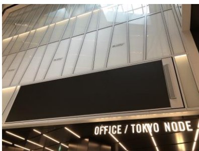
サイネージスピーカー(LED右横)JBL Intellivoxシリーズ ※LEDビジョンはヒビノクロマテックDiv
